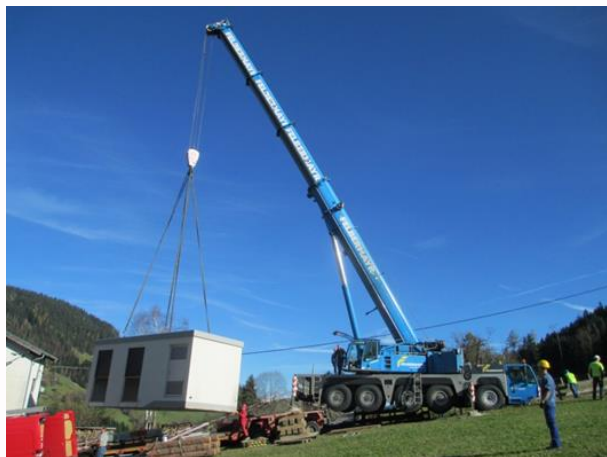
Abbildung 14+15: Versetzen mit Dach und ohne Dach
