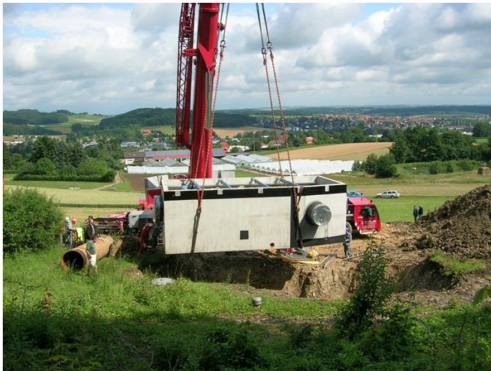
Abbildung 20: Versetzen einer Betonraumzelle mit Gurten
