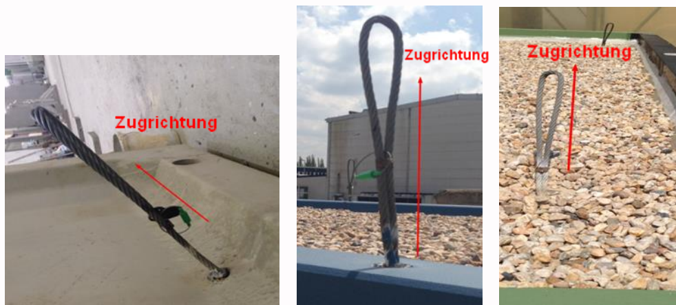
Abbildung 21: Zugrichtung der einbetonierten Transportanker
