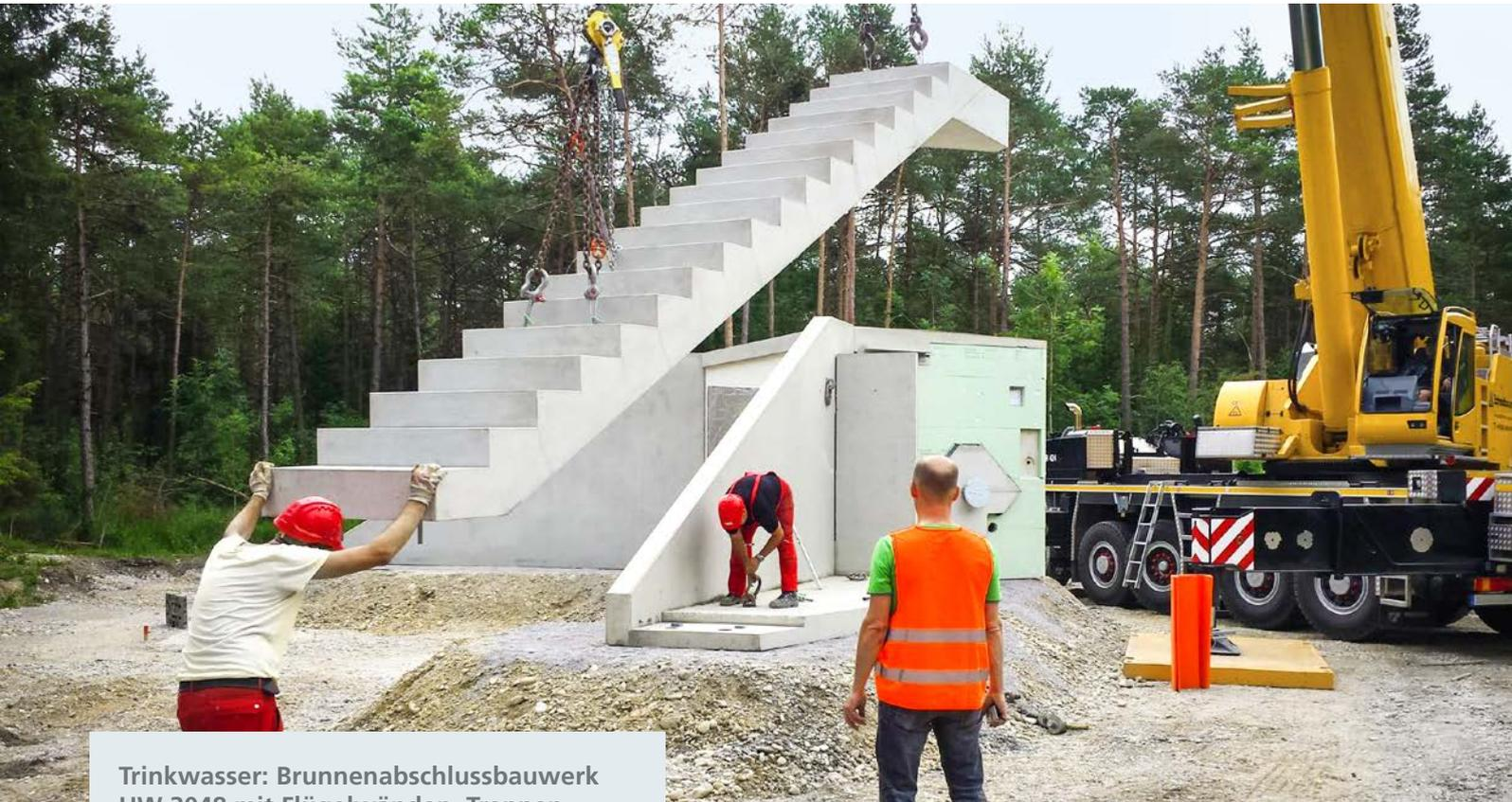
Trinkwasser: Brunnenabschlussbauwerk UW 3048 mit Flügelwänden, Treppenaufgang, WDVS-Fassade und ebenerdigem Zugang
