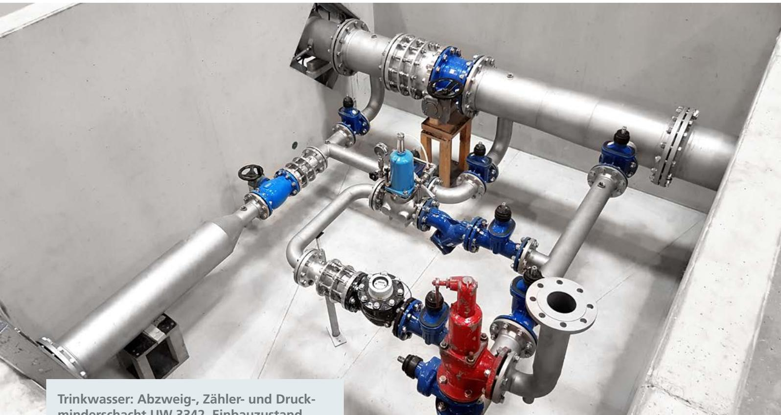
**Trinkwasser: Abzweig-, Zähler- und Druckminderschacht UW 3342, Einbauzustand**
