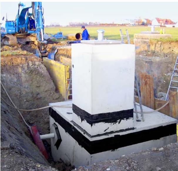
Trinkwasser: Spülschacht UW 3036 am Tiefpunkt der Hauptleitung DN 400, Spülleitung seitlich abgeführt
