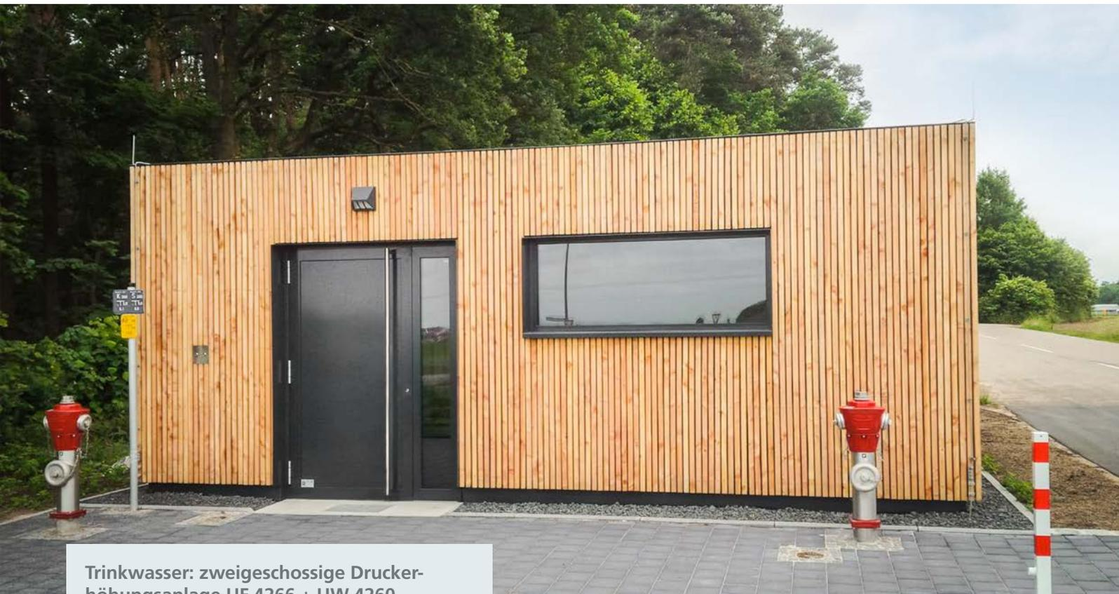
**Trinkwasser: zweigeschossige Druckerhöhungsanlage UF 4266 + UW 4260, Fassade aus Lärche-Profilleiste**
