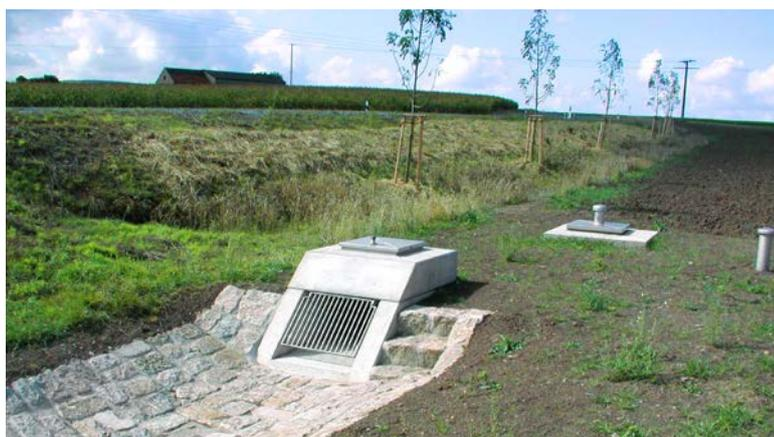
Der mit Trinkwasser in Berührung stehende Baustoff Beton wird ohne Zusatz von organischen Rohstoffen auf „saugenden“ Schalungen verarbeitet. Der weitere Ausbau erfolgt grundsätzlich mit für Trinkwasser ausdrücklich zugelassenen Werkstoffen. Die Axiallasten aus dem Innendruck in den Rohrleitungen werden bei Bedarf zuverlässig in die Bauwerke eingeleitet und abgefangen. Die entsprechende statische Gestaltung erfolgt im Fertigteilwerk.
