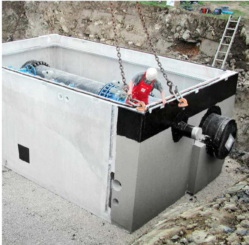
Trinkwasser: zweiteiliger Abzweig- und Steuerschacht UW 4266 + 3066, Installation Hauptleitung DN 1000
