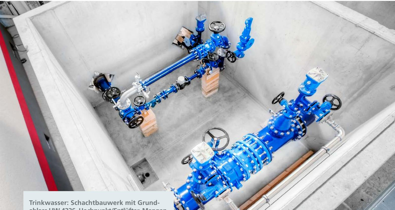
Trinkwasser: Schachtbauwerk mit Grundablass UW 4236, Hochpunkt/Entlüfter, Mengenzählung und Druckminderung, Installation Hauptleitung DN 400
