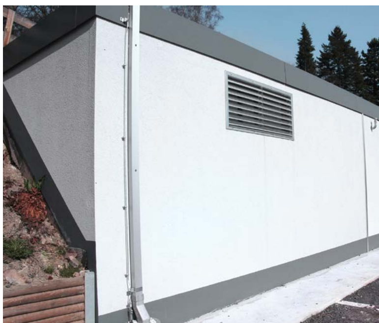
Beispielstation im Hangeinbau Example station in slope installation
