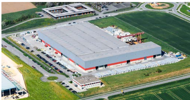
Standort Kösching Location Kösching
